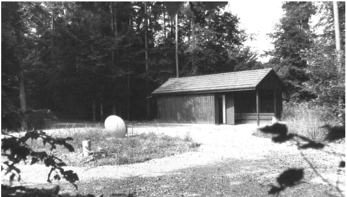
Uferfiltratpumpwerk Eggholz, Betriebsgebäude mit Trafostation und Filterbrunnen 1
