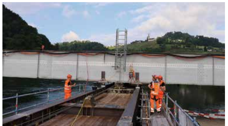
Auf diesen Schienen wurde die Brücke transportiert
